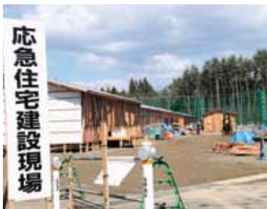
仮設住宅の建設が進む(平成23年7月頃)
