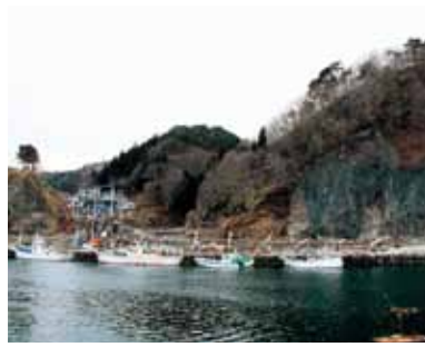
震災後の魚市場。建屋すべてが流失した
