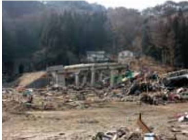
倒壊した駅舎と橋脚
